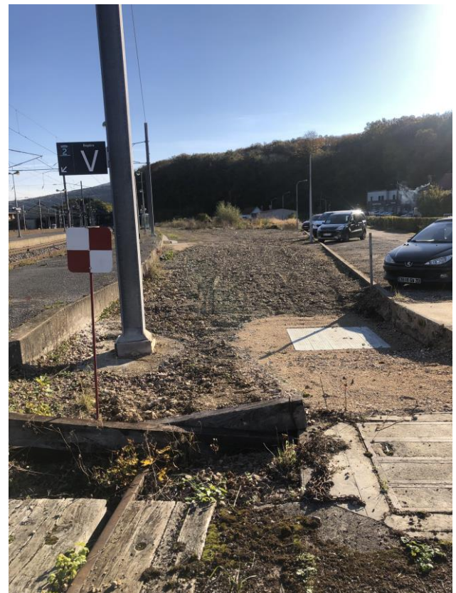
Vue de la libération de l'ancienne plateforme « marchandises »
