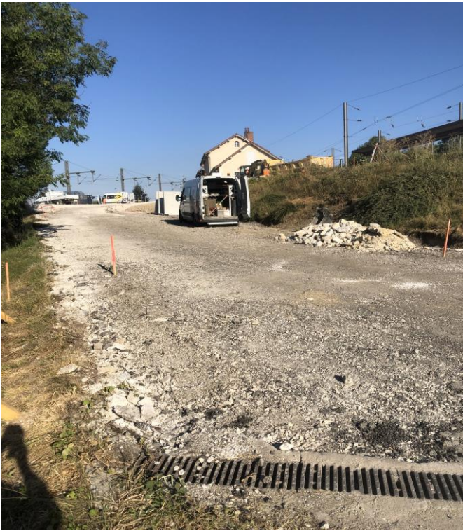
Rampe ...de sortie de la gare
