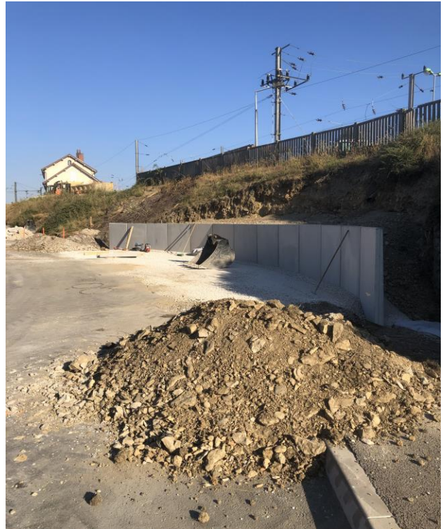
Elargie pour faciliter la circulation des bus
