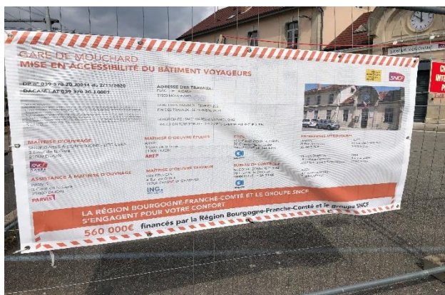
Vue du panneau de chantier
